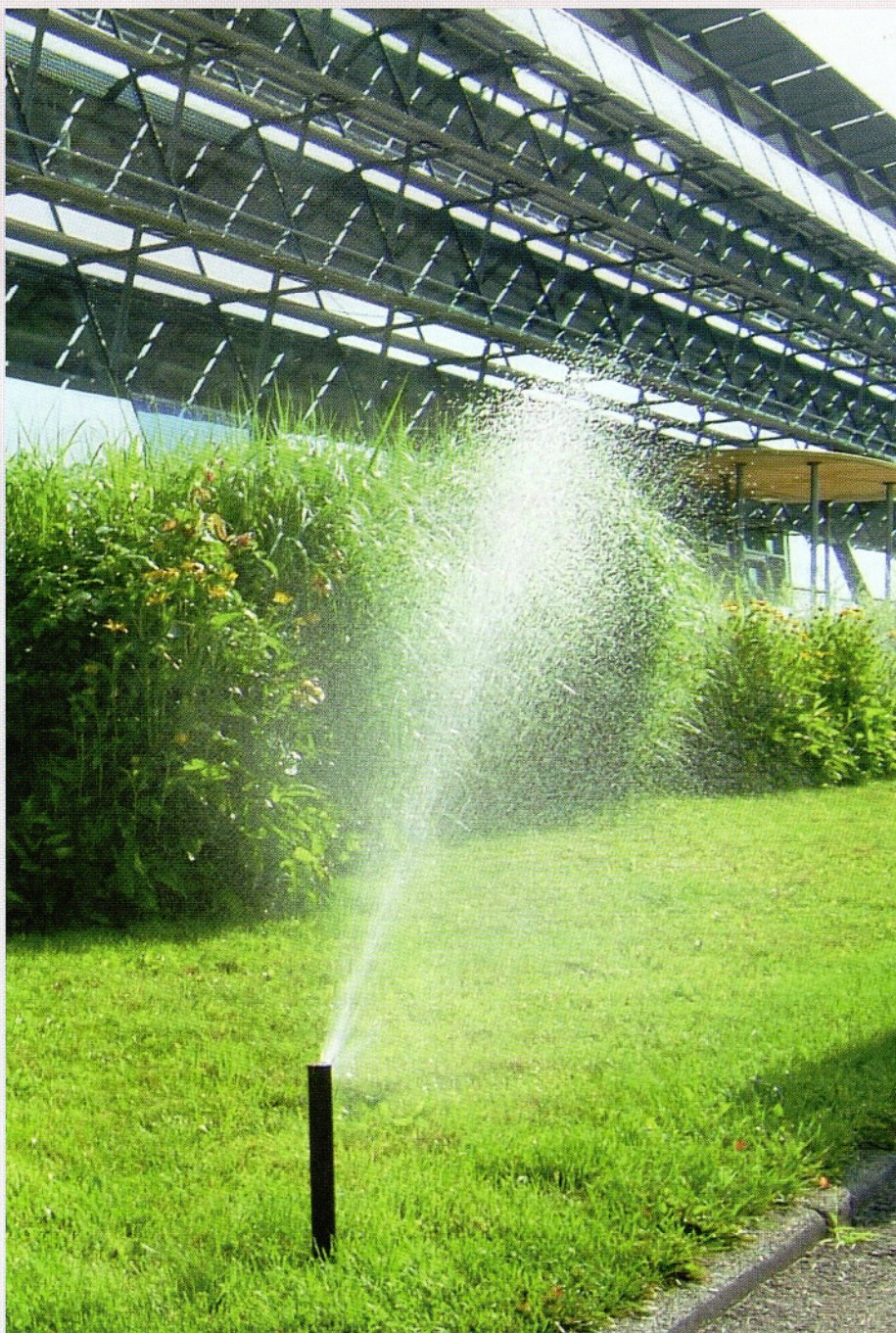
Bild 1 Unterflur-Beregnungsanlagen: Werden sie aus dem Trinkwassernetz gespeist, gehören sie nach den Regeln der Technik zur Kategorie 5 und benötigen eine Trinkwassertrennstation als Sicherungseinrichtung.
